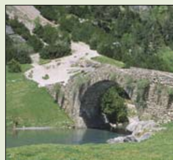
Puente Romano de Bujaruelo.
