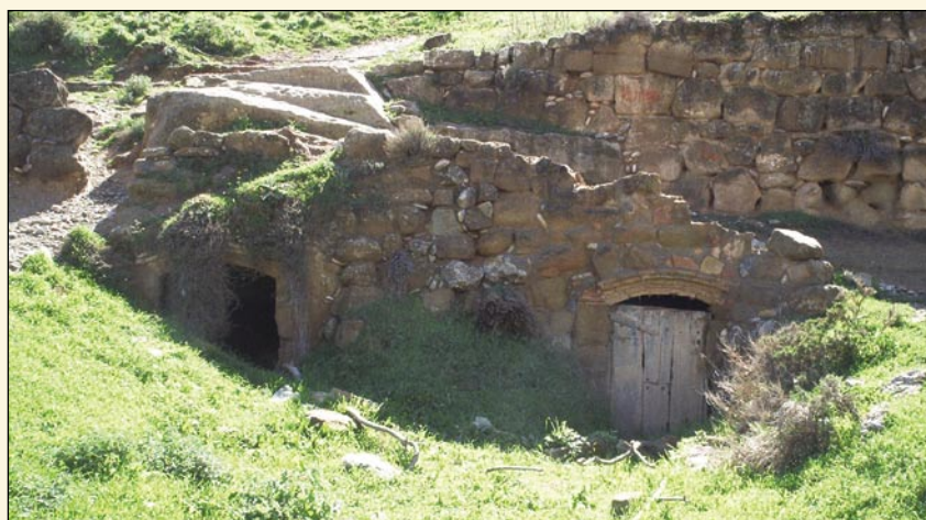
Recuperación de antiguas bodegas excavadas en la roca (Pueyo de Santa Cruz).
