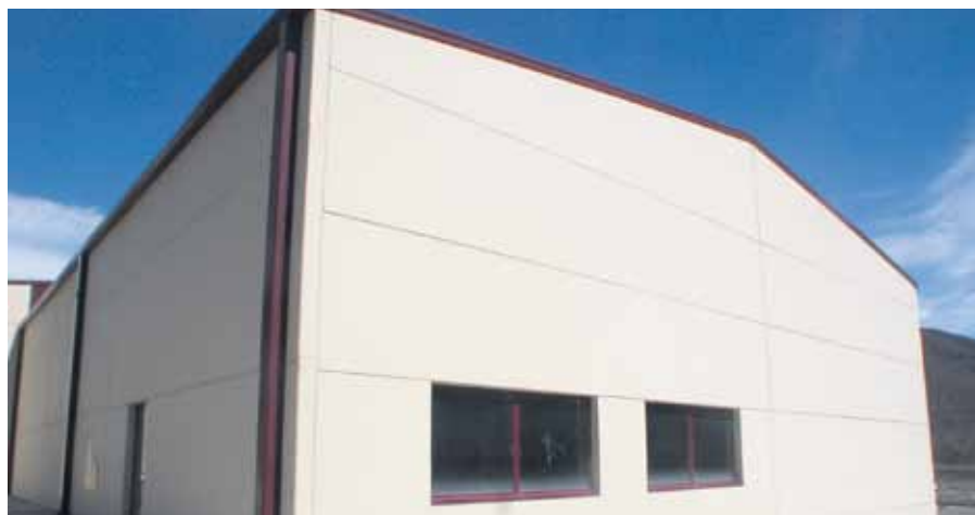
▲ Exterior del próximo vivero agroalimentario en el polígono Las Pasaderas, en Biescas.
