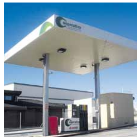
Estación de servicio de la Cooperativa agrícola Ntra. Sra. del Pilar de Novallas.
