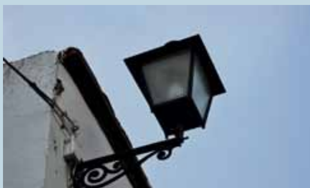
▼ Sustitución de luminarias poco eficientes.
