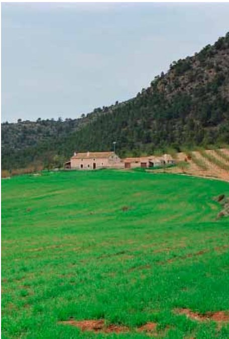
▲ Vivienda unifamiliar con espacio para el ganado, Campo de San Juan (Caravaca de La Cruz, Murcia).
