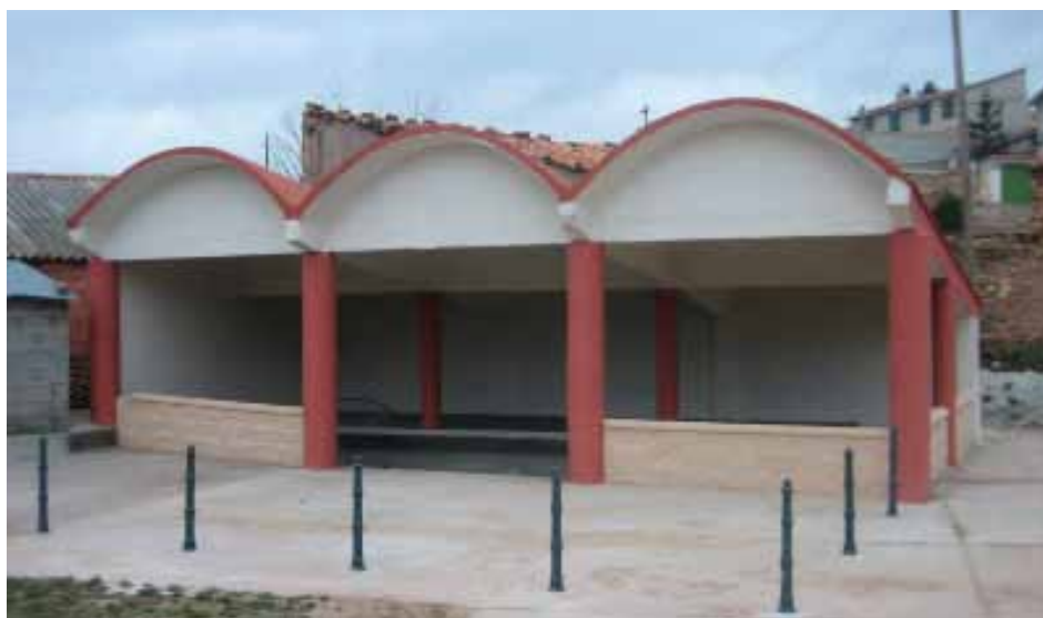
▲ Rehabilitación del lavadero municipal de Pancrudo.
