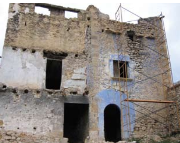
▲ Ruinas de una masía que se rehabilita para uso turístico, preservando la arquitectura tradicional.
