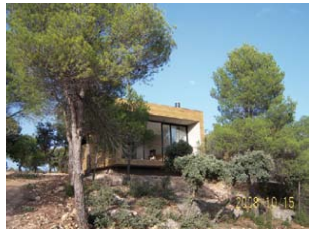
▲ Nueva construcción turística integrada en el monte. "Matarraña Lodge", en Monroyo.
