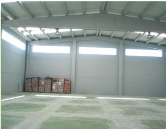
▼ Interior de la nave de Hidromatic.
