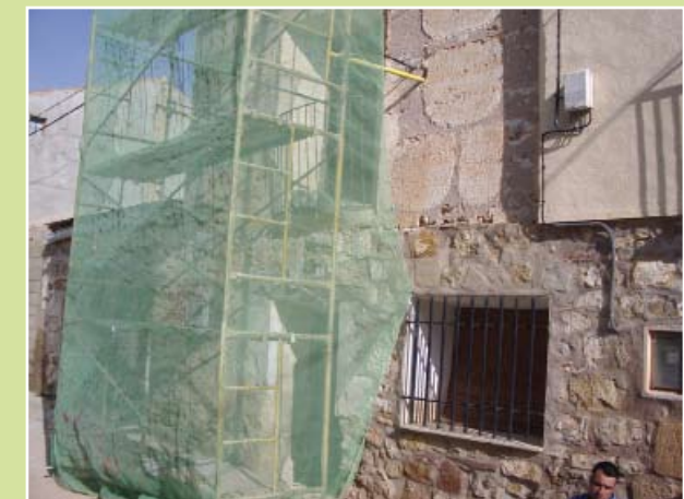
▲ Vivienda de turismo rural en Torremocha antes de las obras.
