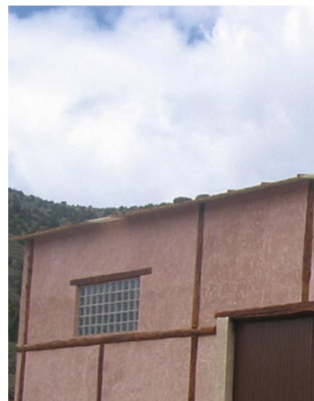
Aplicación del yeso rojo en la nave ▲ de Yesos y Minas.
