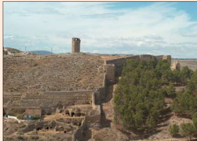
Vista de parte del recinto fortificado islámico de Calatayud (s. IX).
