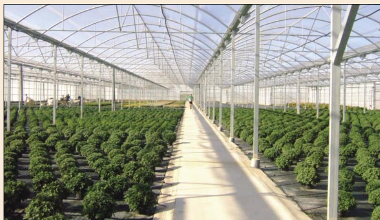
Instalaciones de Viplanta en Tauste.
