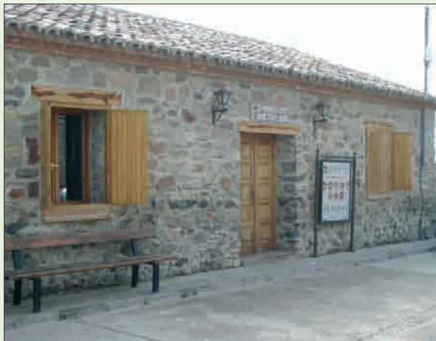
Antiguo horno de Lidón rehabilitado como multiservicio rural.
